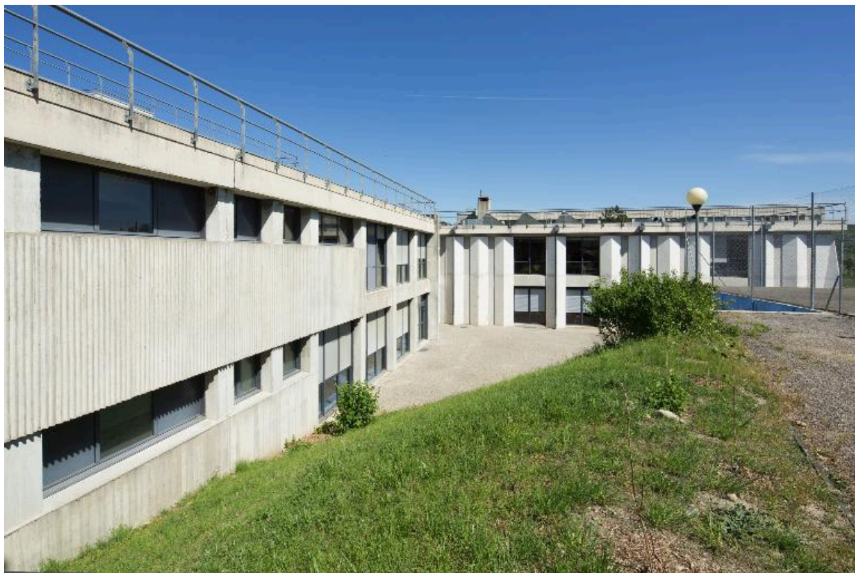
Bâtiment socio-culturel : Liaison entre gymnase et bâtiment socio-culturel
