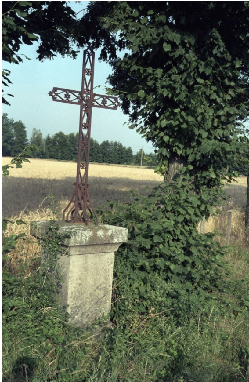
Montverdun, la Queue du bois, croix de chemin en fer forgé de type D3 (1986 C3 525). Vue d'ensemble de trois-quarts.
