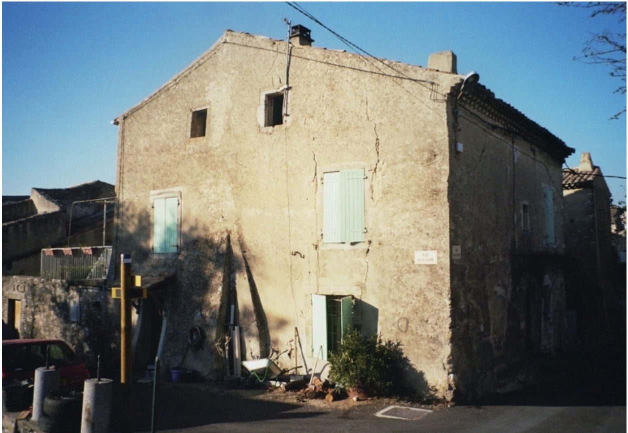
Elévation sur la rue de la Cure de l'ancien presbytère (F 648), dont l'entrée est sur la rue du Rocher.
