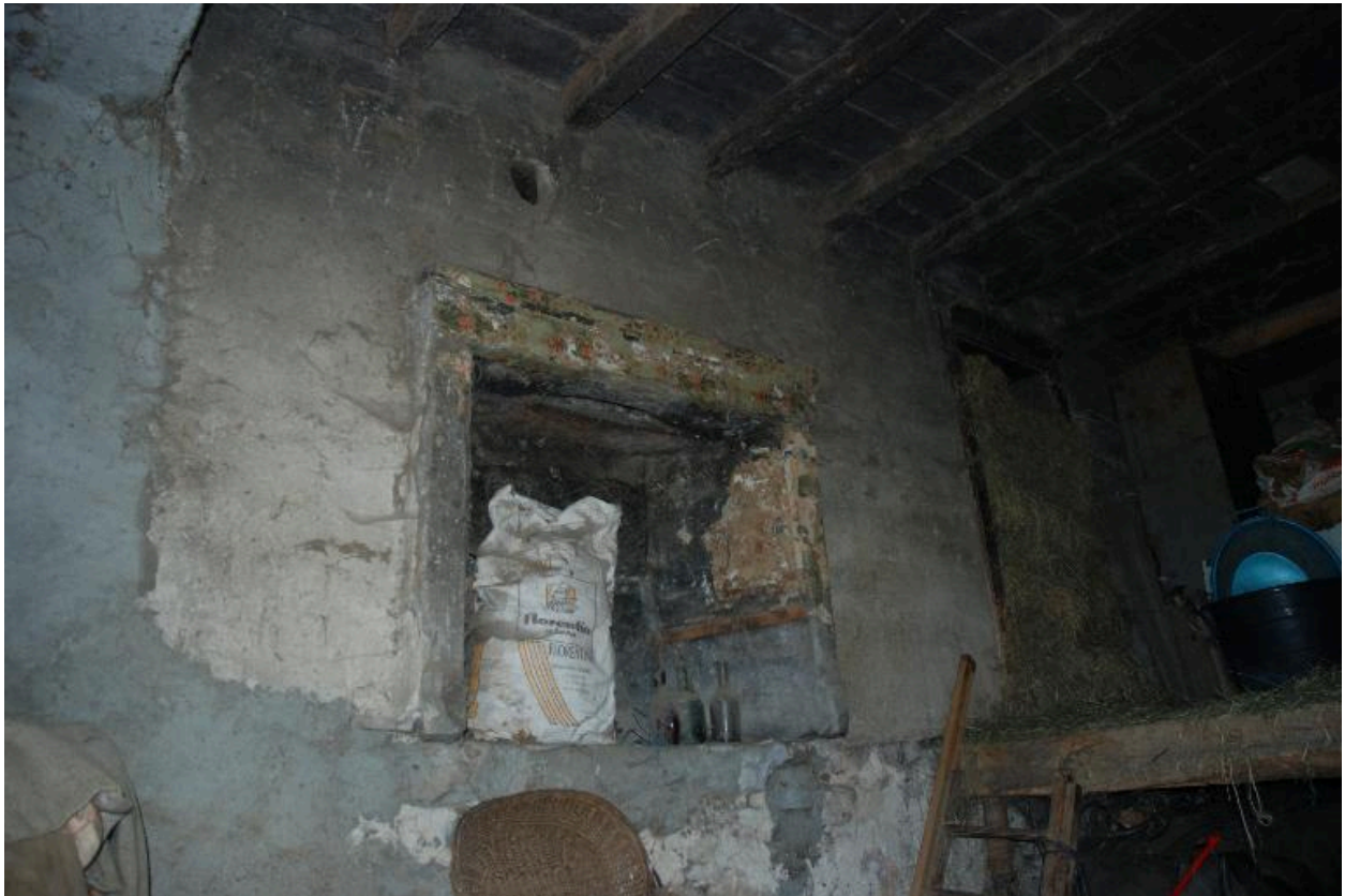
Vue intérieure de la grange-étable : ancien logis de la forge.
