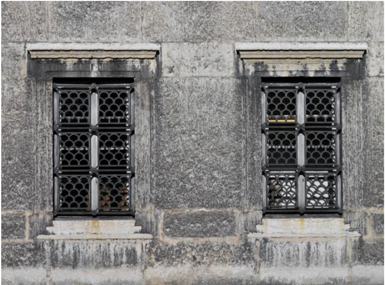
Cour du dépôt : fenêtres fermées de grilles ouvragées
