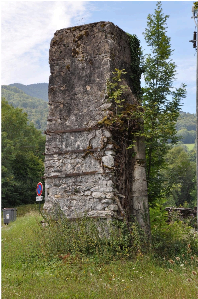
Vue de la cheminée d'équilibre de la conduite d'amenée.
