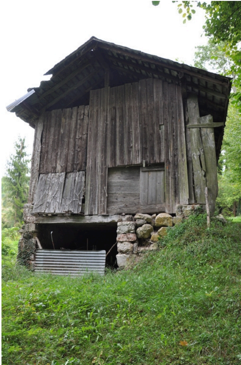
Vue de la façade ouest
