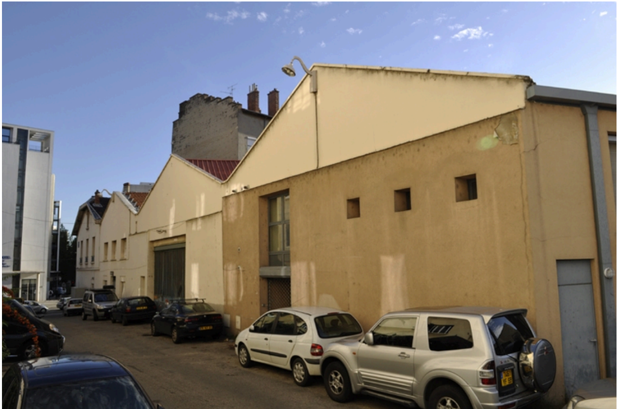
Façades sud du site
