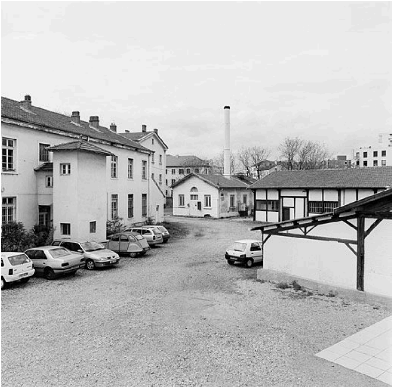
Vue de l'aumonerie, de la chaufferie, du gymnase et de la bibliothèque
