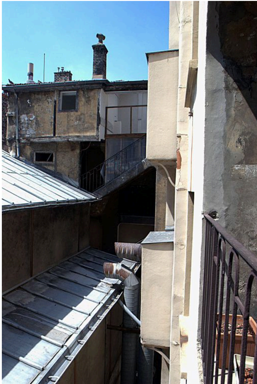
Vue partielle de la cage d'escalier et du corps de bâtiment sur cour, depuis le nord-est
