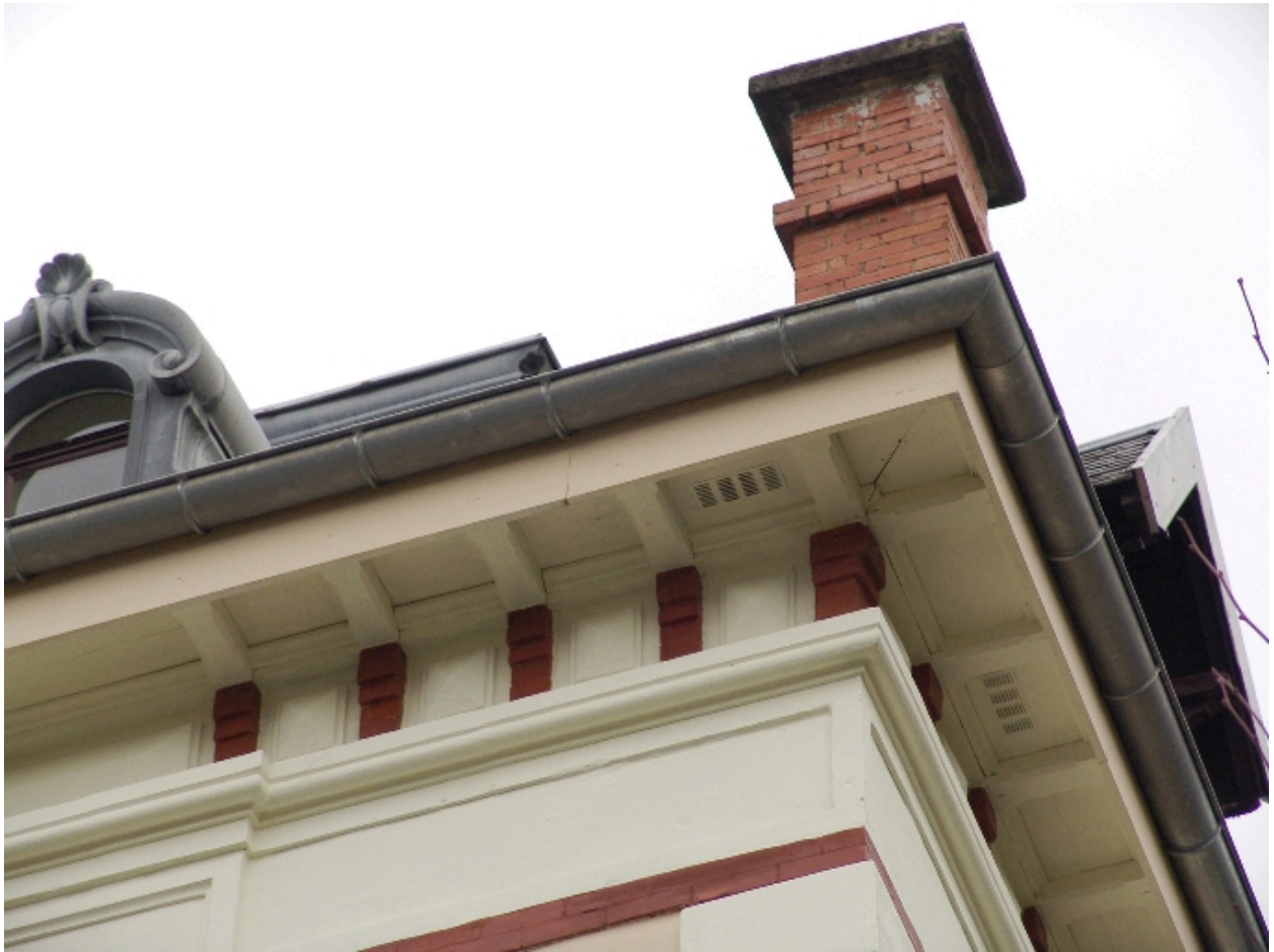
Détail de la fermeture de toit
