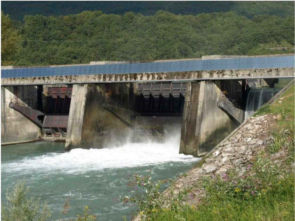
Passe, vue partielle face aval (depuis la rive gauche)
