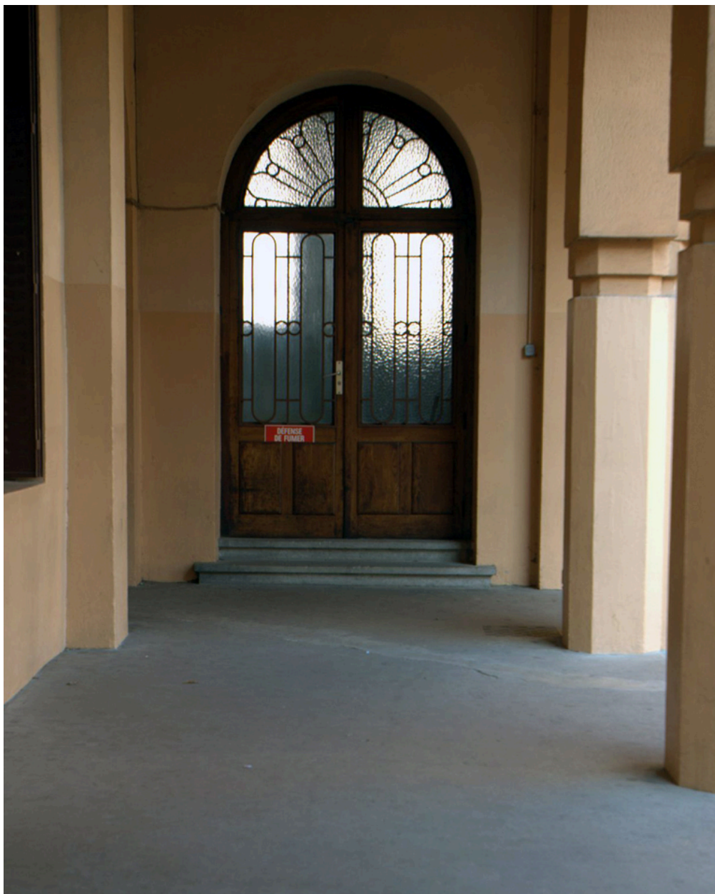
Le portique, vue intérieure depuis le nord ; porte de la conciergerie
