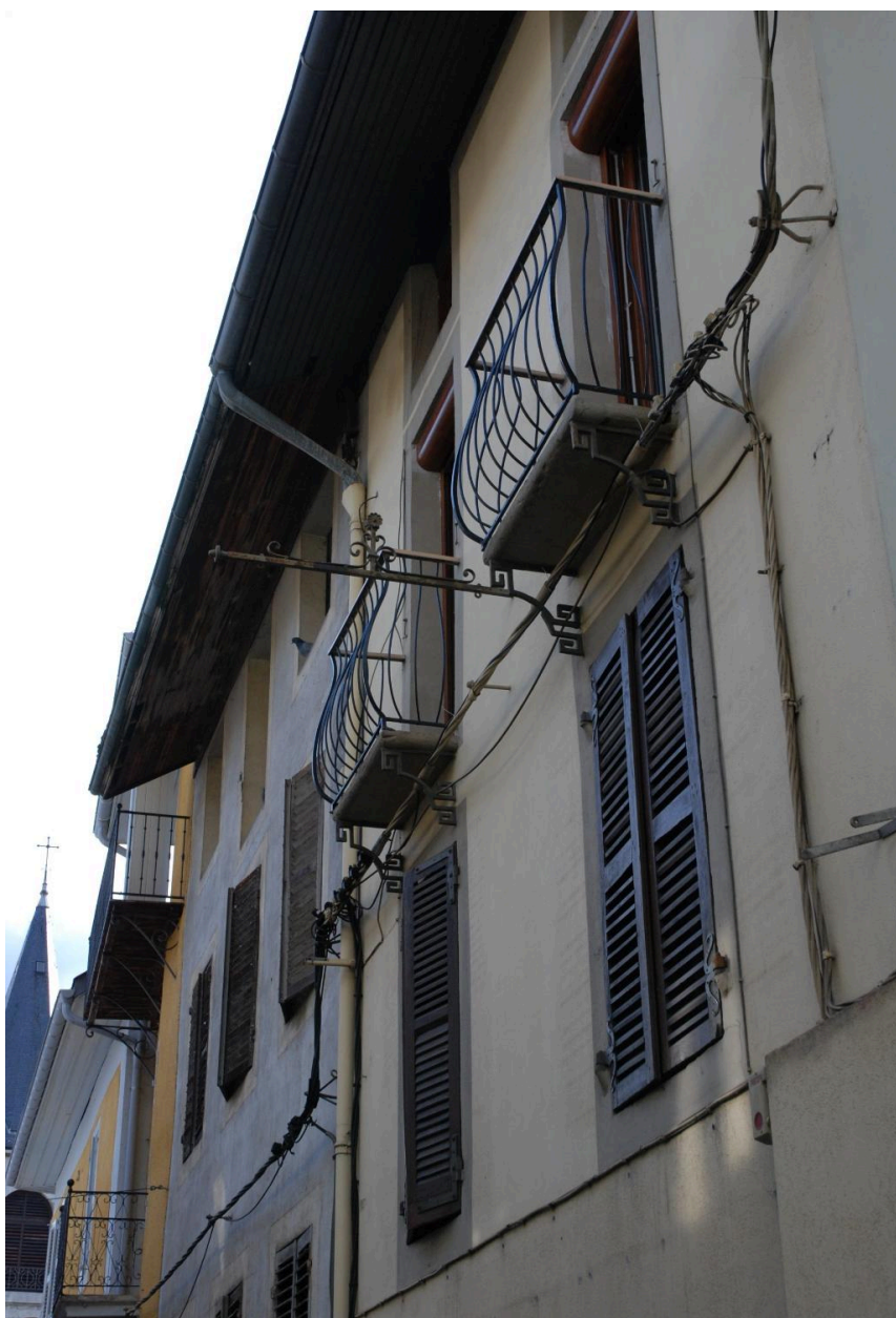
Maison, immeuble 25 rue Jean-Louis Bouvet (2018 E1 274). Détail des balcons à consoles en grecques ; porte-enseigne en fer forgé.
