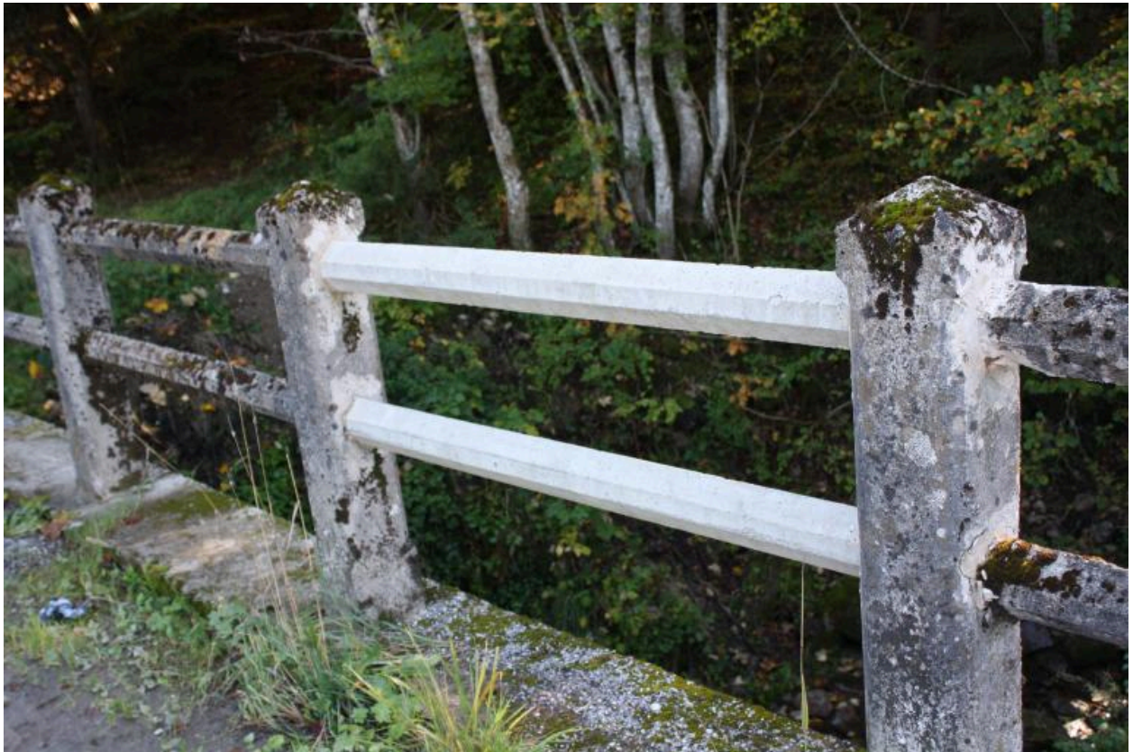
Pont de route de la Villaz, détail garde corps
