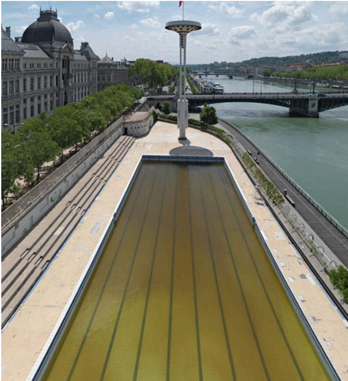
Partie sud de la piscine : vue du bassin de compétition (état en juin 2012).
