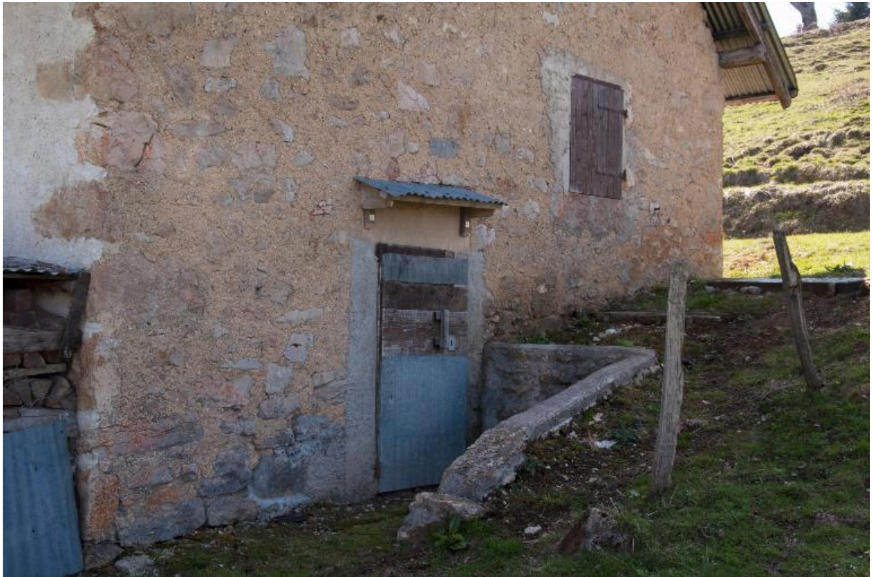
Vue du bâtiment médian (ancien chalet d'habitation sur cave), entrée de la cave sur le mur nord.
