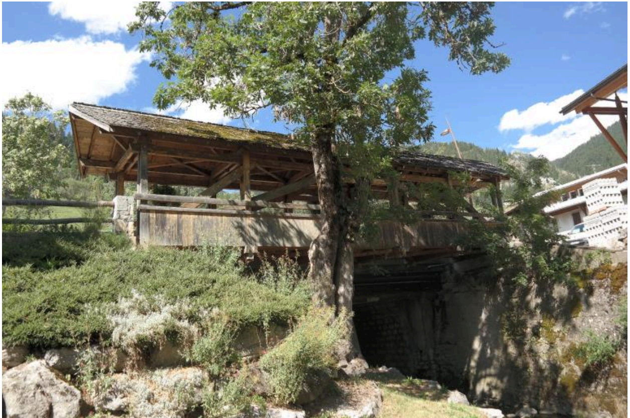
Pont du Nant de la Ville, vue de la face aval
