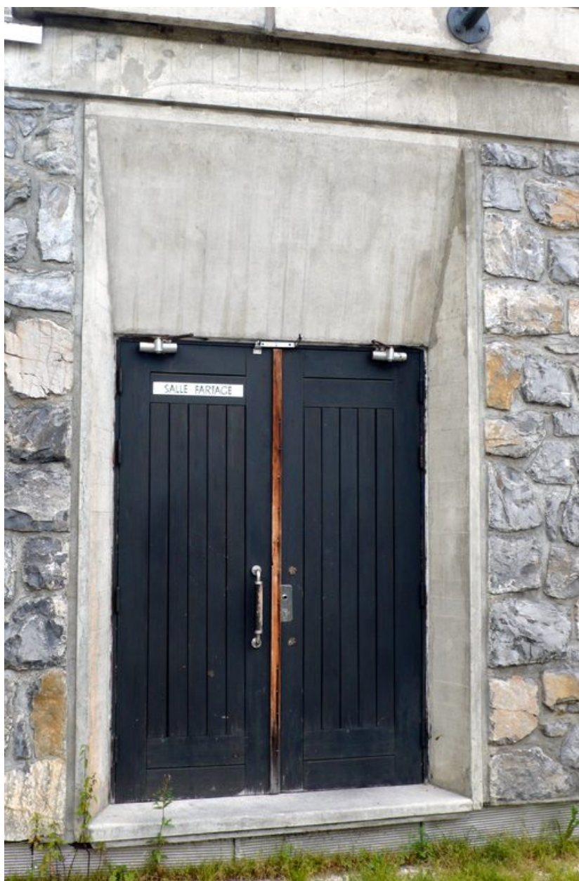
Pignon ouest. Entrée de la salle de fartage
