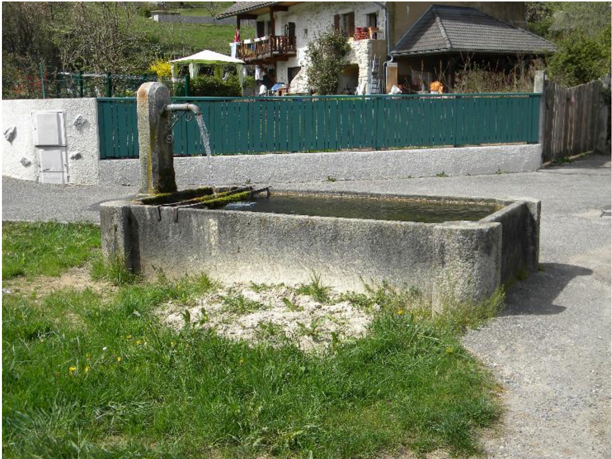
Vue du bassin sud du chemin des Fontaines.
