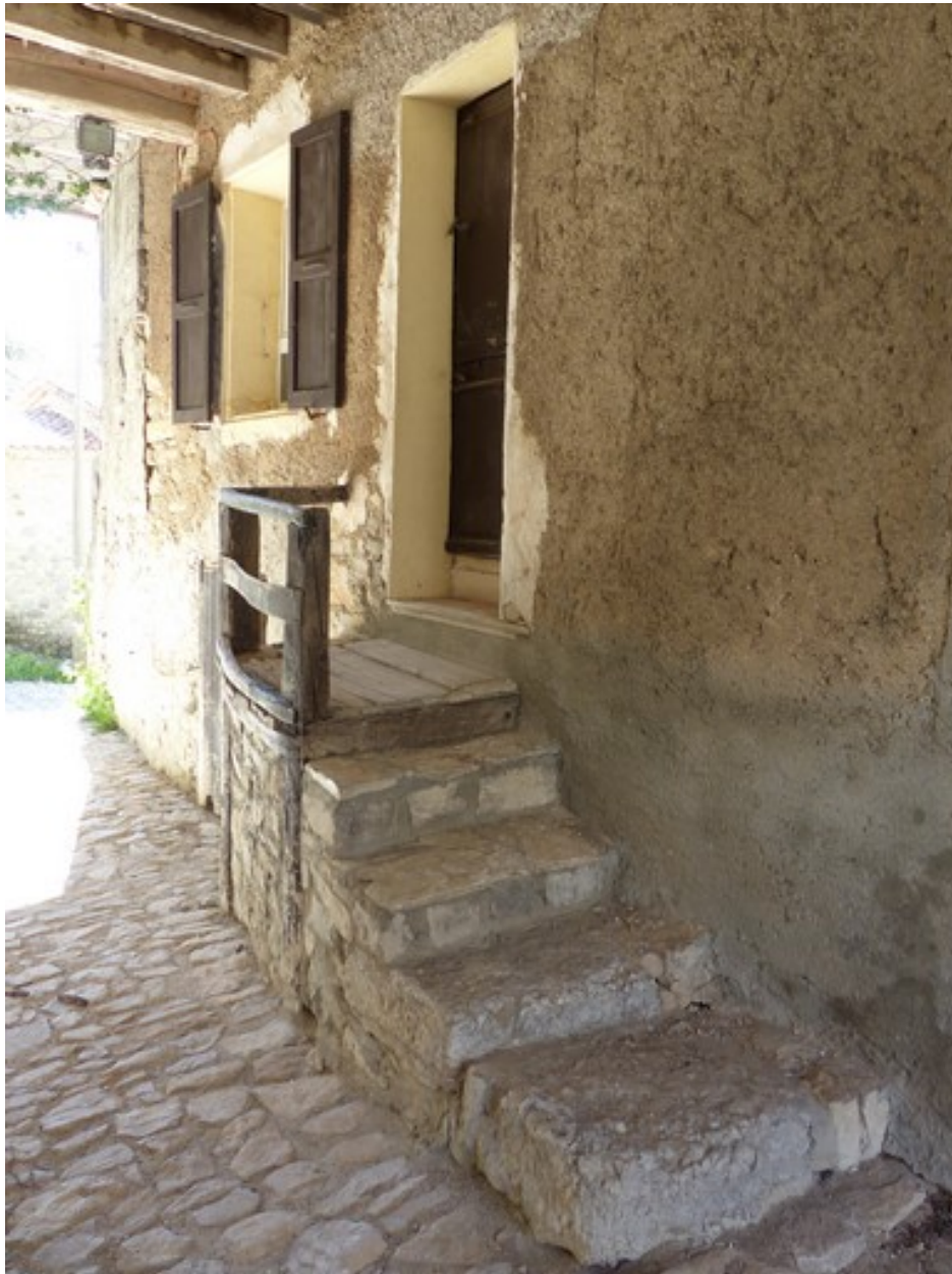
Elévation est, sous le passage couvert. Escalier extérieur.
