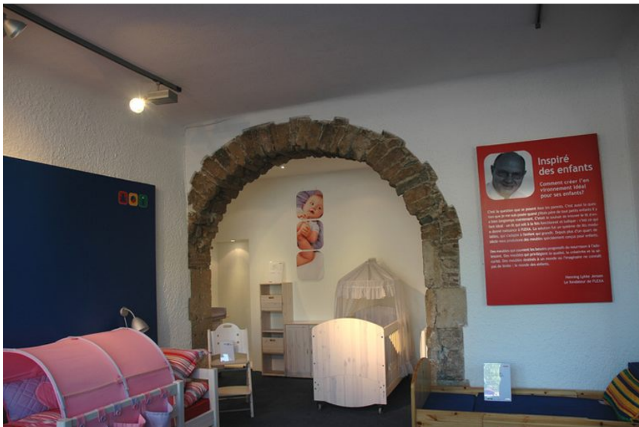
Couvent : 9 quai des Célestins, magasin Flexa, corps de bâtiment encore en élévation : arc de passage en plein cintre
