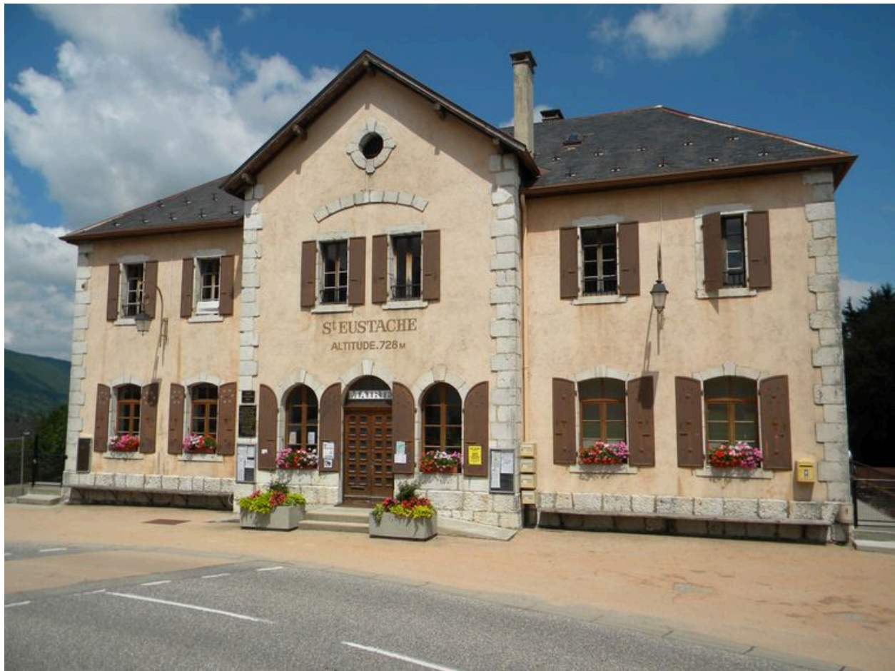
Vue générale de la façade principale.
