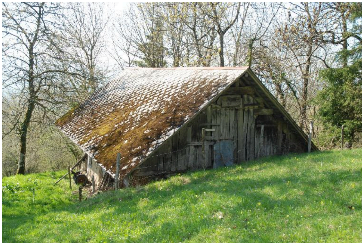
Vue du pignon amont.
