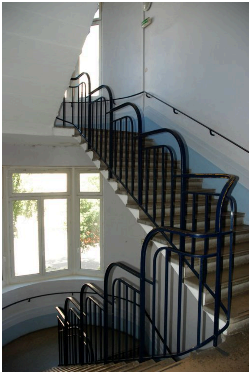
Vue sur la cage d'escalier centrale, premier étage
