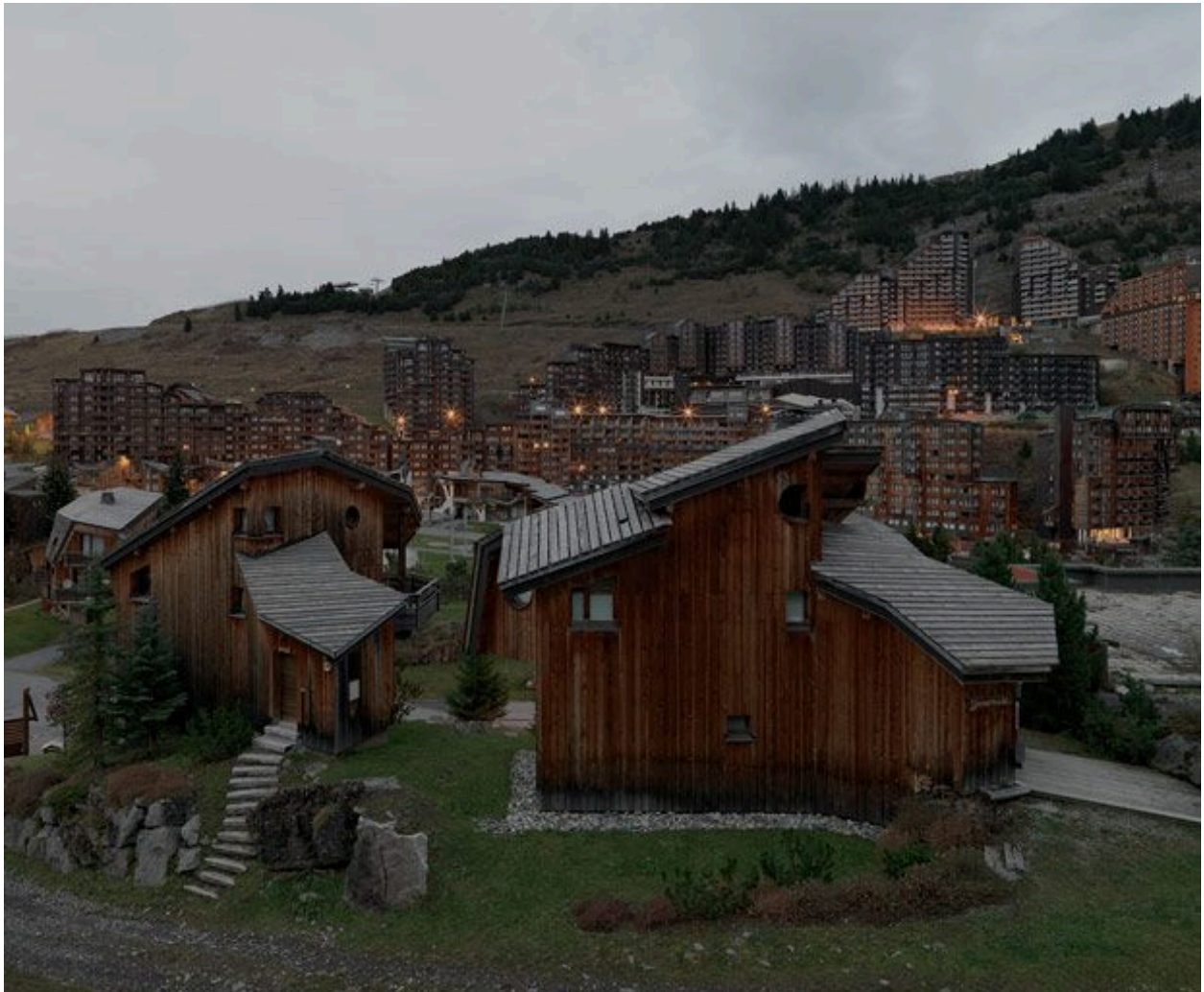
Vue d'ensemble des chalets Ours II (à gauche) et Yosémite depuis l'ouest
