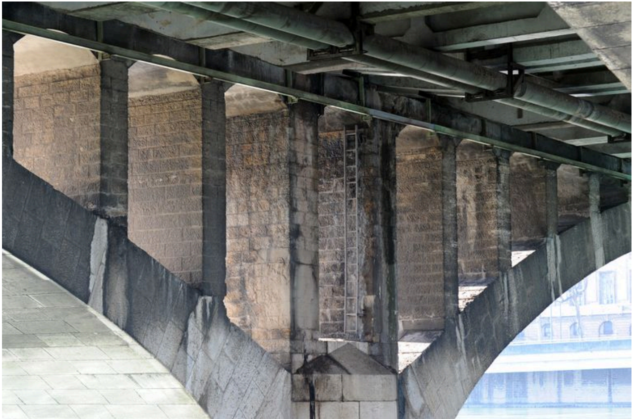
Arches, de dessous, face aval, vue partielle : jonction avec la pile et avec le tablier (depuis la rive gauche)
