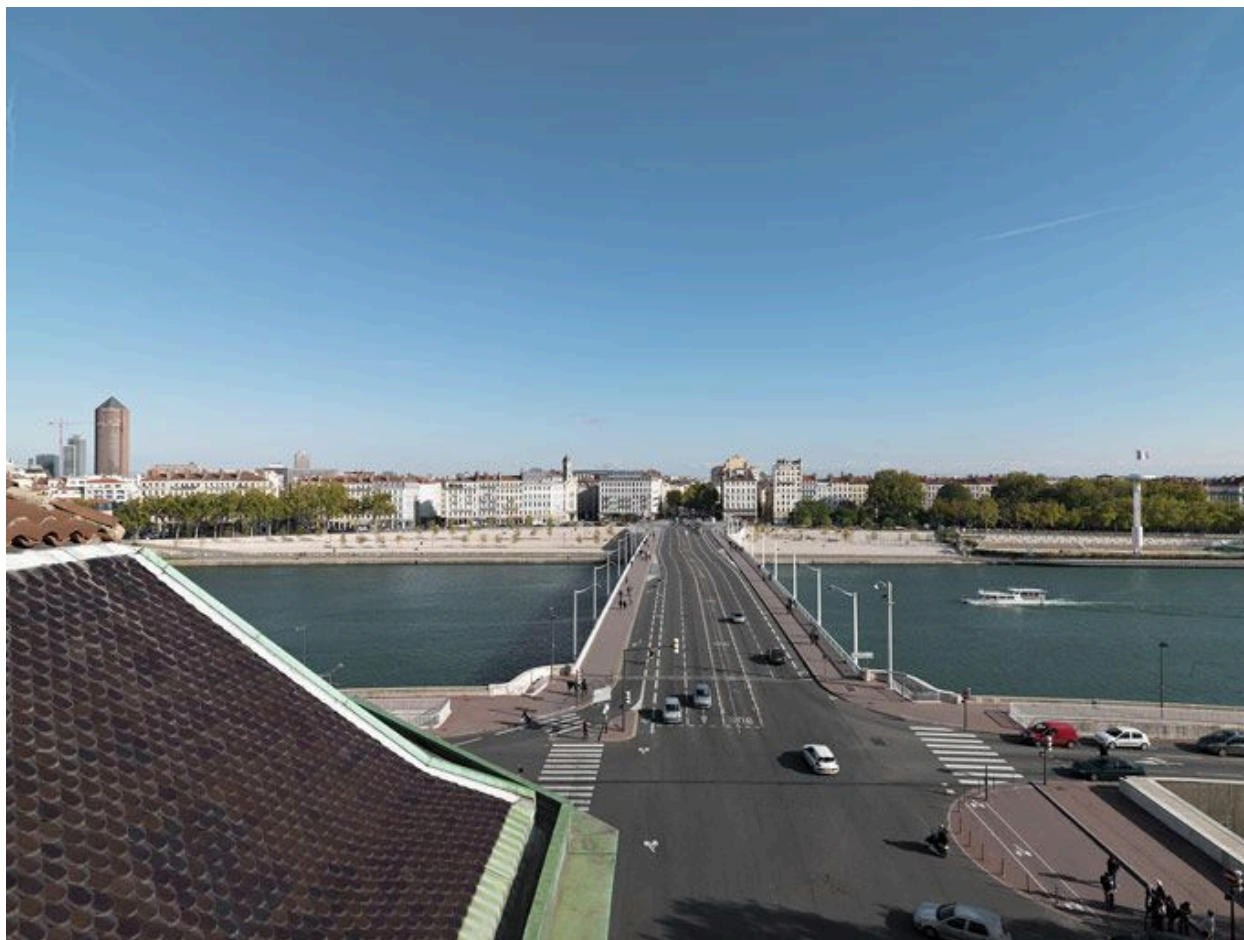
Vue d'ensemble du pont depuis les toits de l'Hôtel-Dieu à l'ouest
