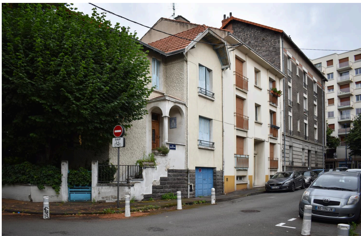
Façades sur la rue Montgolfier
