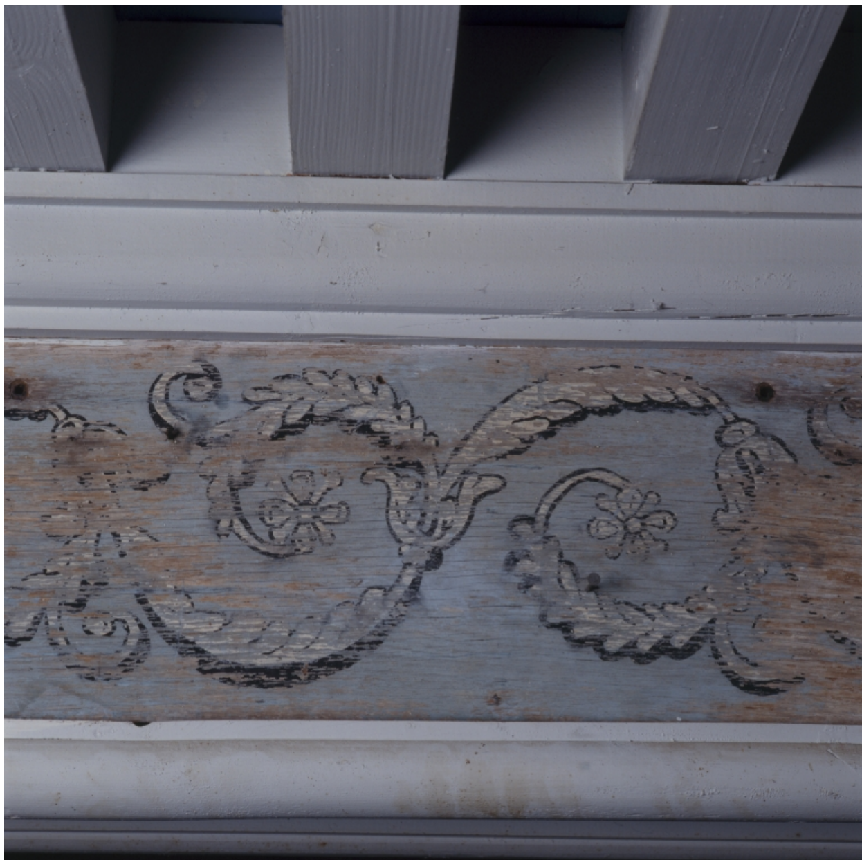
Corps de logis nord-est, premier étage, salle dite du Grand Juge située au nord : détail intérieur des rincaux peints sur les poutres.
