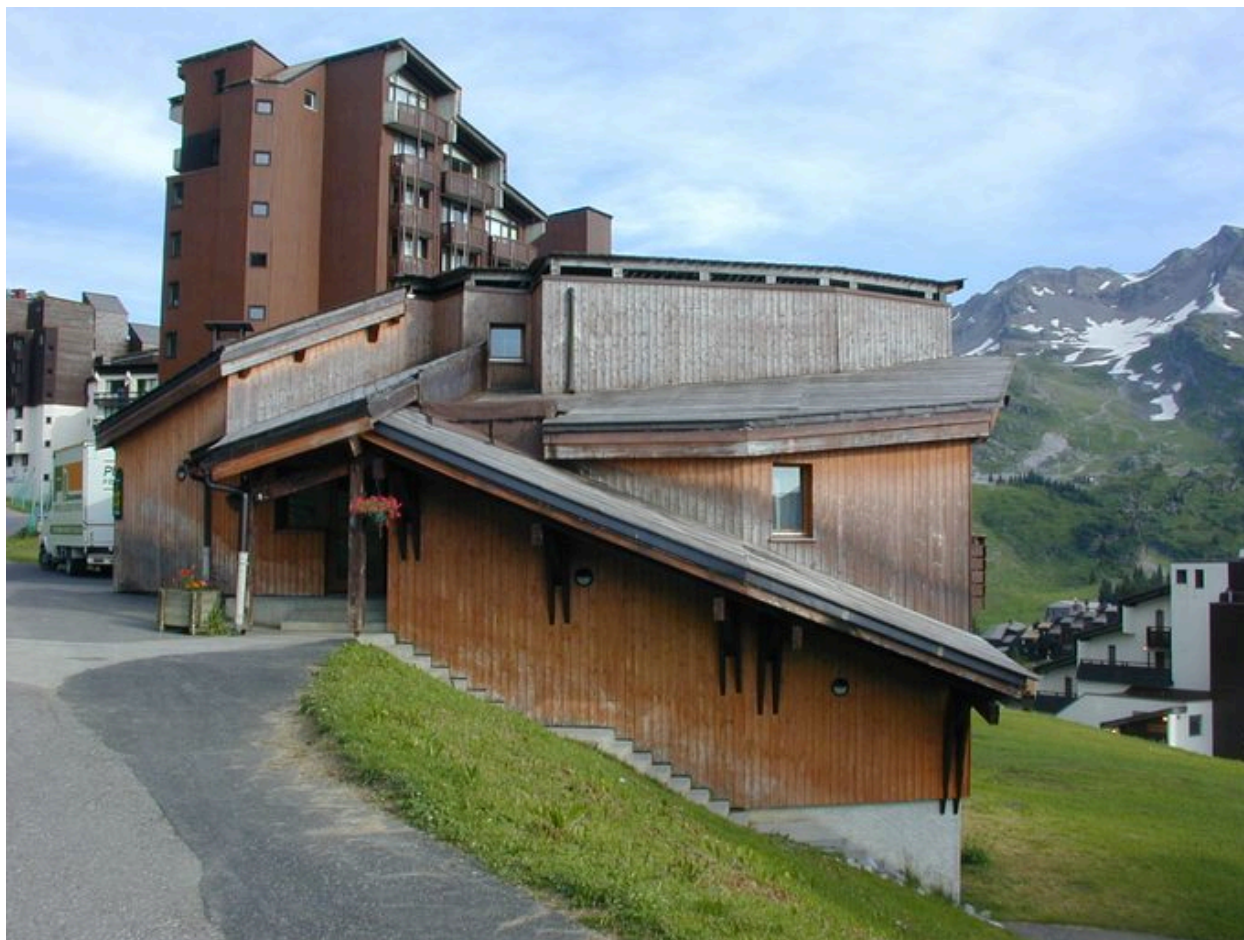
Vue d'ensemble du pignon ouest
