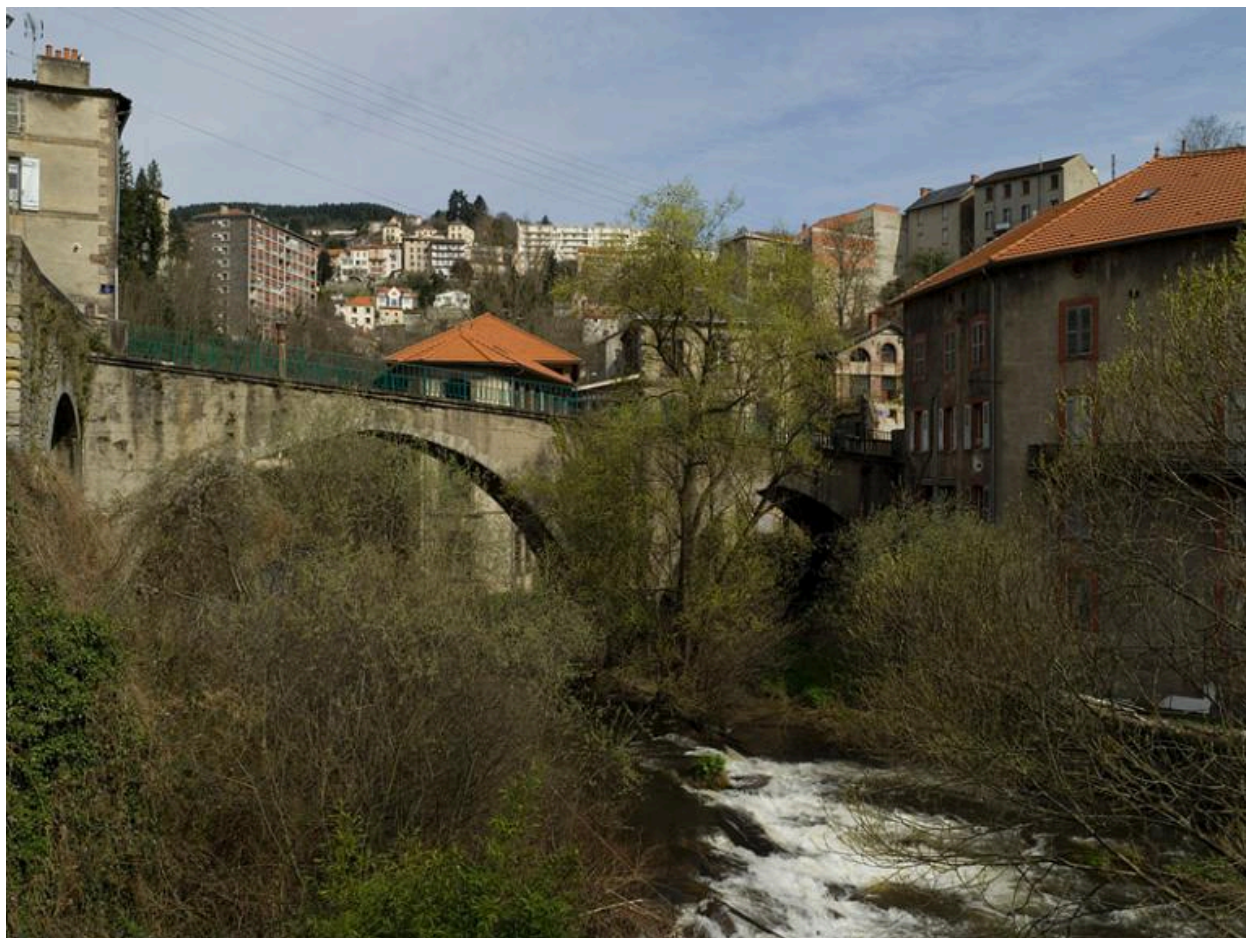
Le pont sur la Durolle et ses abords, depuis l'aval.
