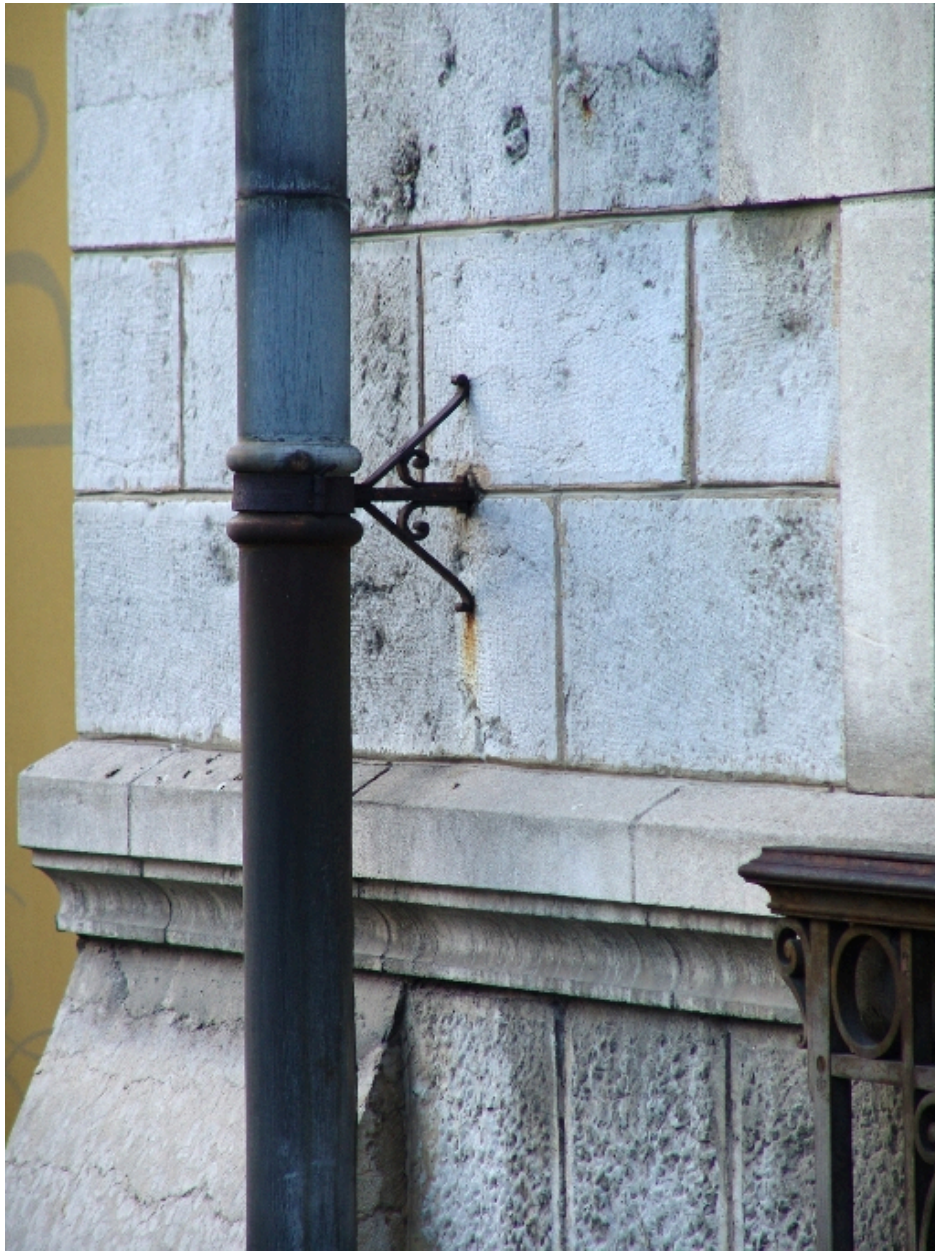
Détail des fixations d'un tuyau de descente
