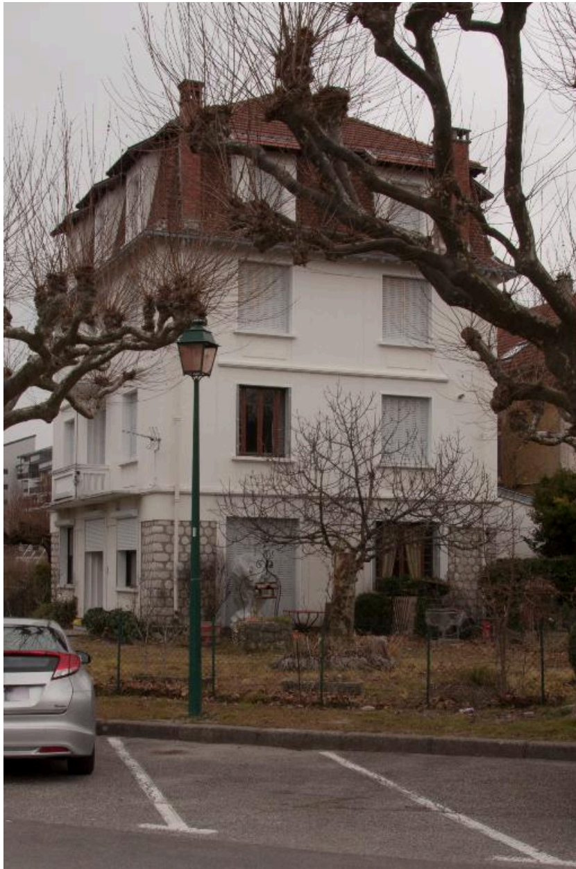
Immeuble Besson : façades ouest et sud
