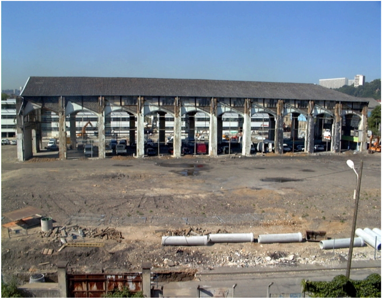
Vue d'ensemble nord de la halle de la navigation
