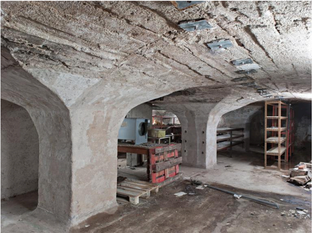
Hôtel-Dieu de Clermont-Ferrand. L'hôtel-Dieu, corps de bâtiment ouest, salle voûtée au centre de l'étage de soubassement..
