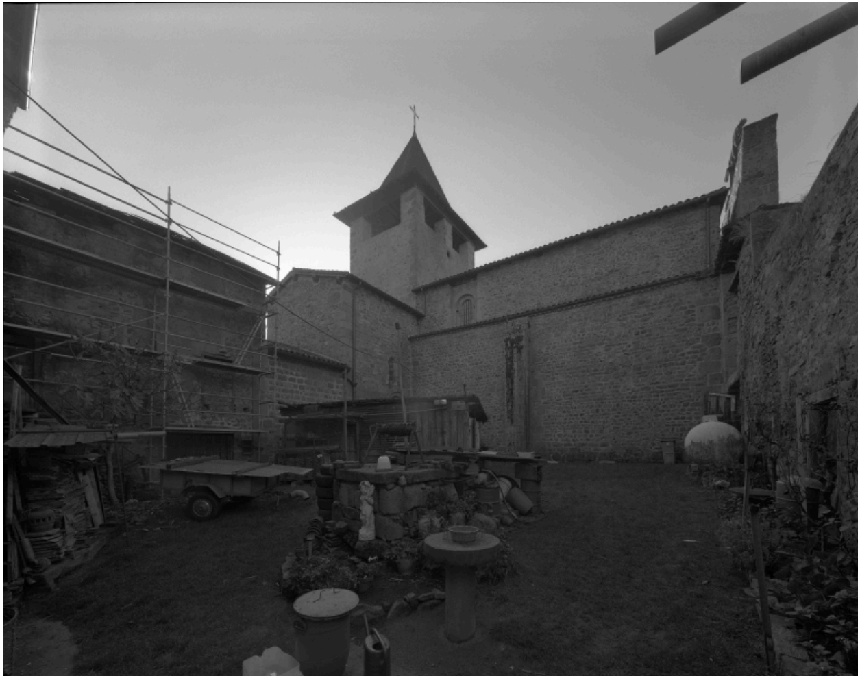
Vue d'ensemble de la façade nord.
