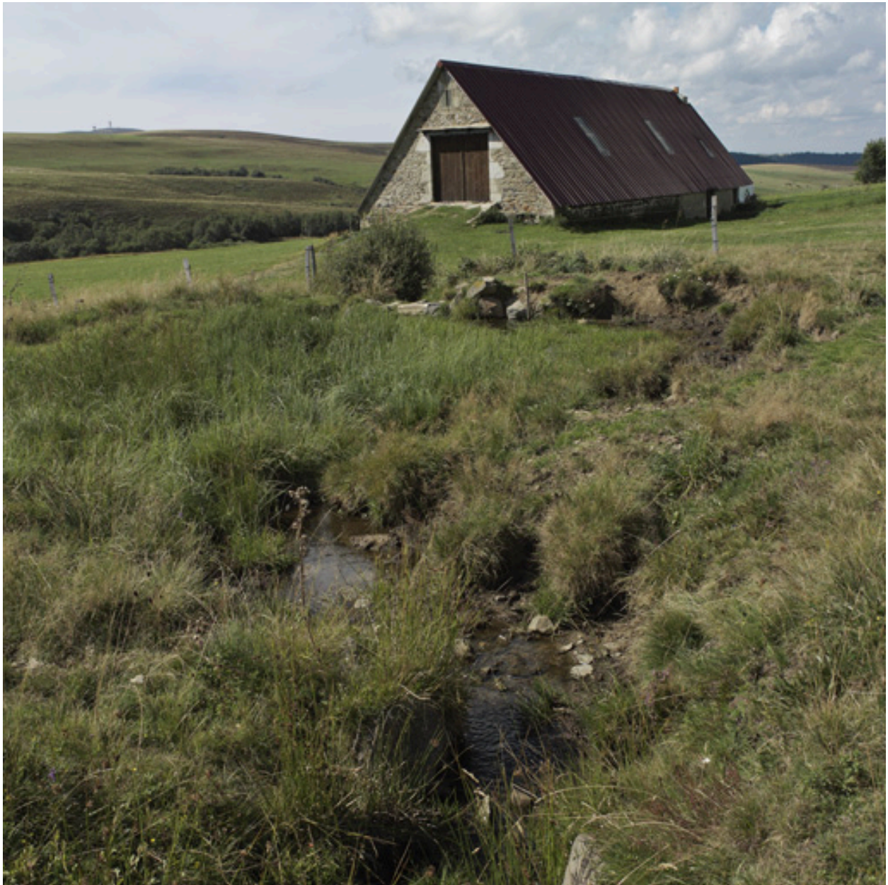
Rigole de circulation d'eau.
