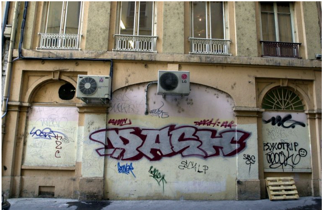
Façade sur la rue Valfenière, rez-de-chaussée vu de face
