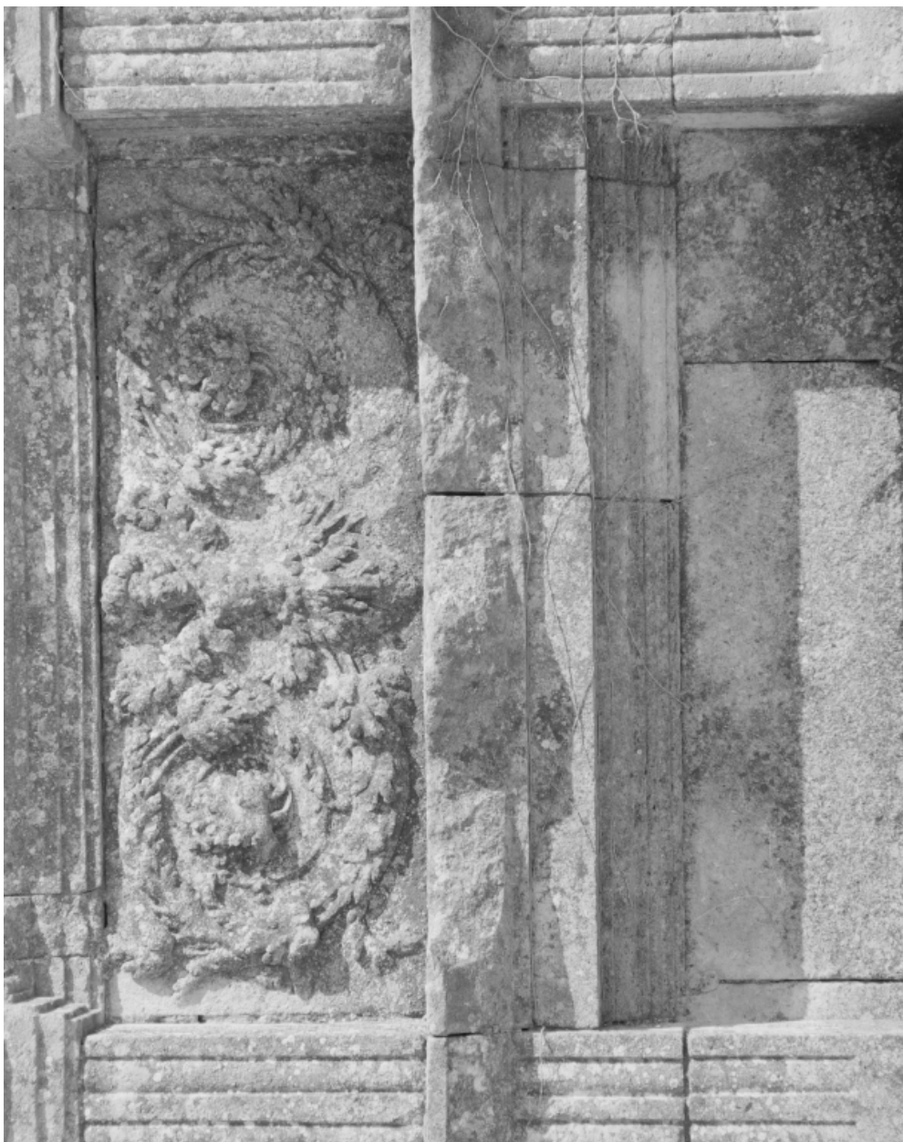
Cour du puits. Façade sud. Troisième travée de la frise sculptée.
