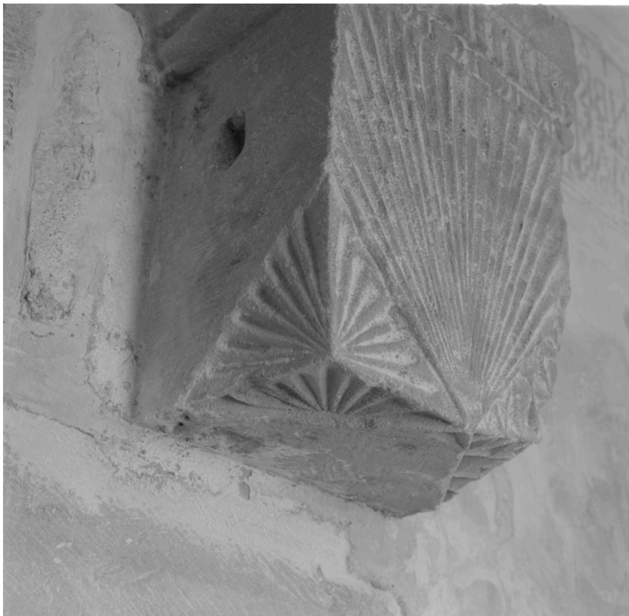
Corbeau à décor géométrique, recevant les retombées des arcs formerets nord, détail côté droit.
