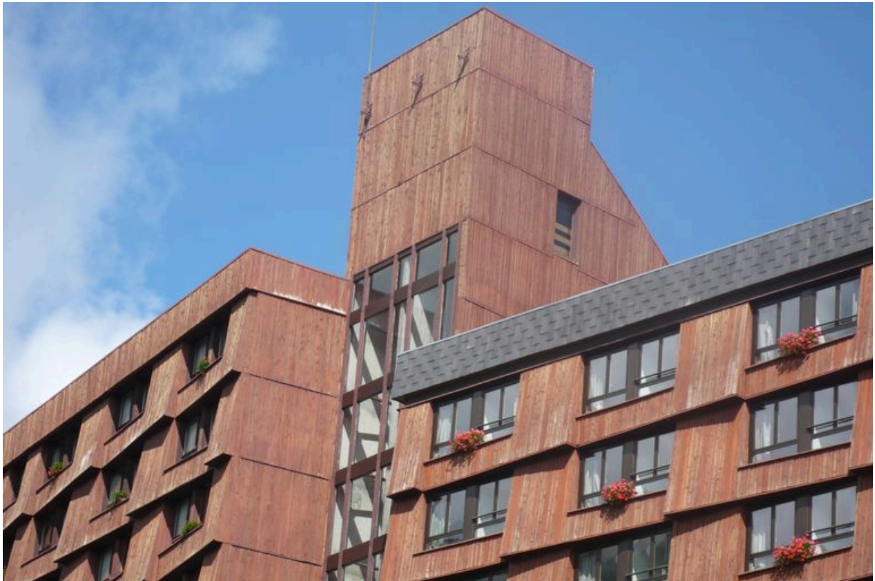
Détail de l'ascenseur panoramique à la jonction entre Horizons nouveaux et Azurèva
