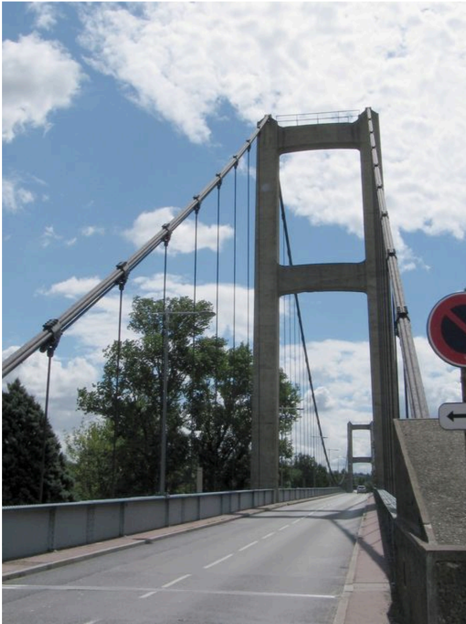
Vue générale, de dessus (depuis la rive droite)
