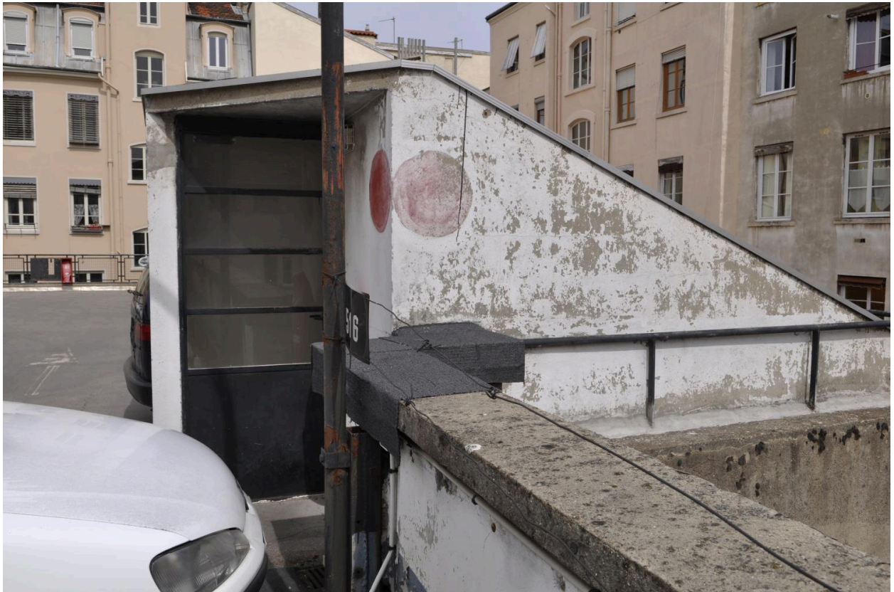
Détail de la porte d'accès du parking extérieur
