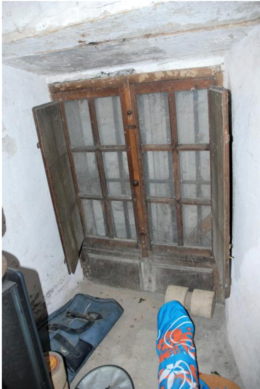
Corps principale, rez-de-chaussée, partie sud, réduit ouest, détail de la fenêtre avec volets intérieurs (Cf. Plan RDC 6a).
