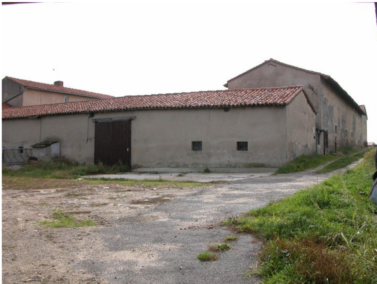
Vue extérieure de l'angle nord-ouest de la ferme
