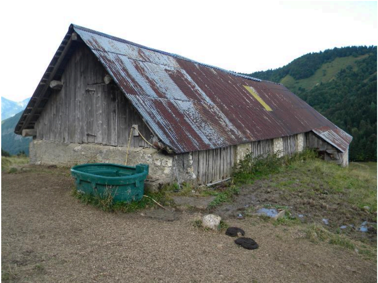
Vue de trois-quarts nord-est du bâtiment principal.
