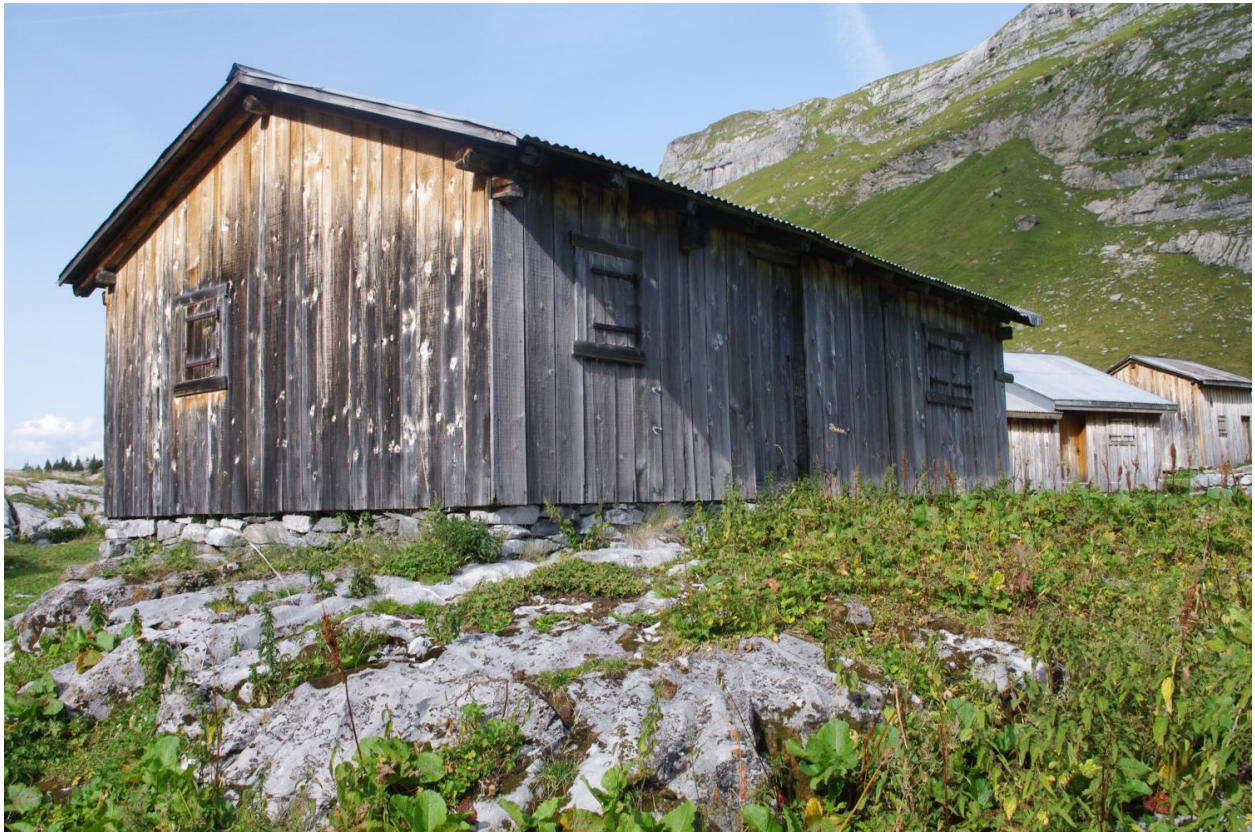
Vue de l'élévation sud-ouest
