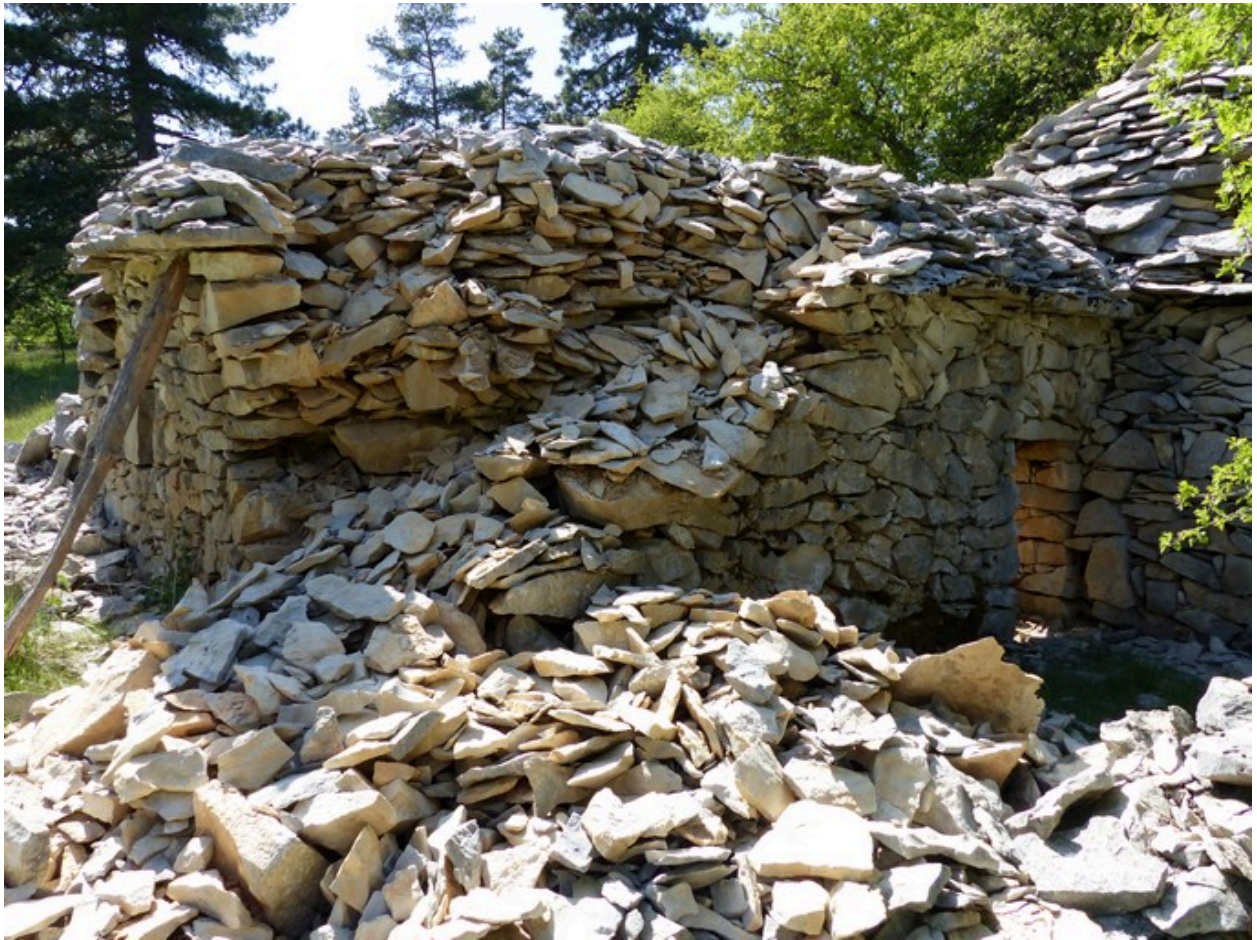
Cabane sud. Vue d'ensemble prise du nord-est.
