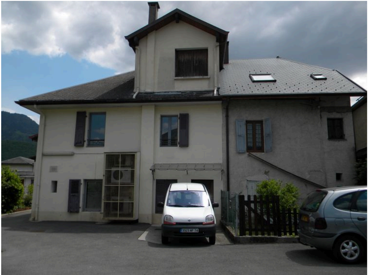
Façade arrière d'une ancienne ferme, actuelle banque (C5 717, 1930).
